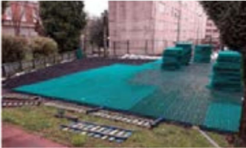
□ Plataforma drenaje sostenible SUDS, Atlantis Otxarkoaga (Bilbao)
